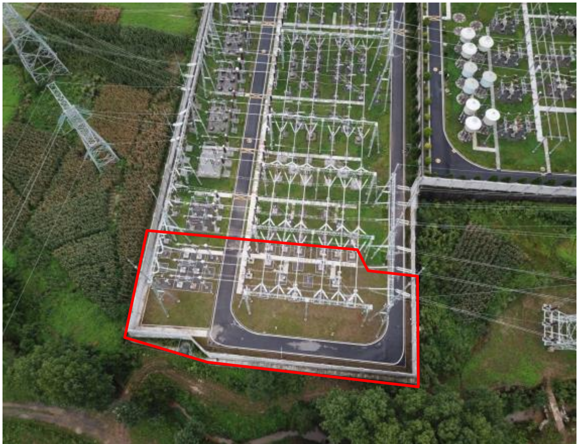
图 1-2 220kV 送出间隔扩建
