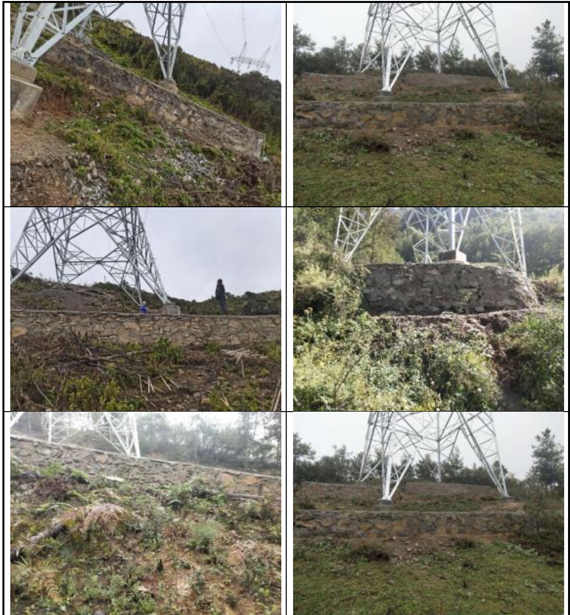
塔基工程区护坡
