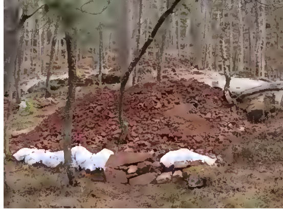
塔基施工场地区土袋拦挡
