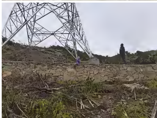
塔基工程区浆砌石护坡
