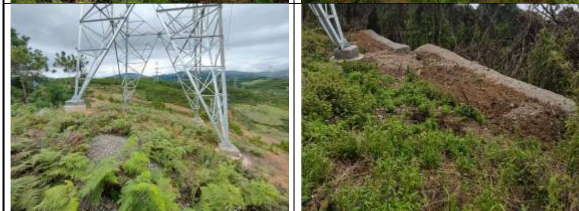
塔基施工场地区撒播植草
