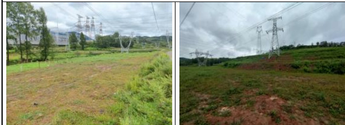
电缆沟区撒播植草
