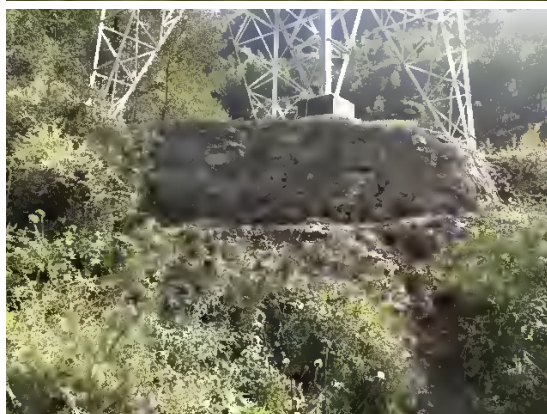
塔基工程区浆砌石护坡
