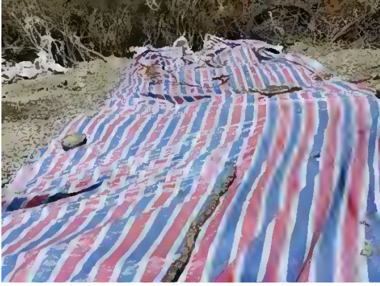
塔基施工场地区彩条布苫盖
