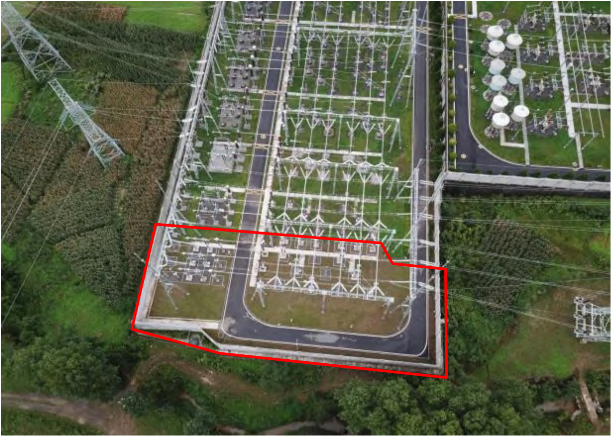
图 1-2 220kV 送出间隔扩建
