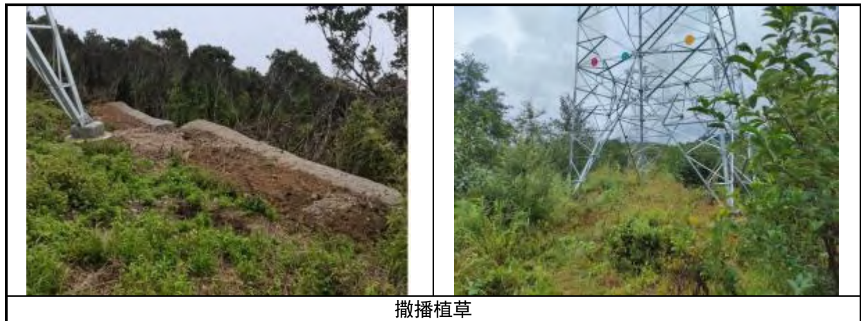
图 3-2 塔基工程区水土保持措施现状图
