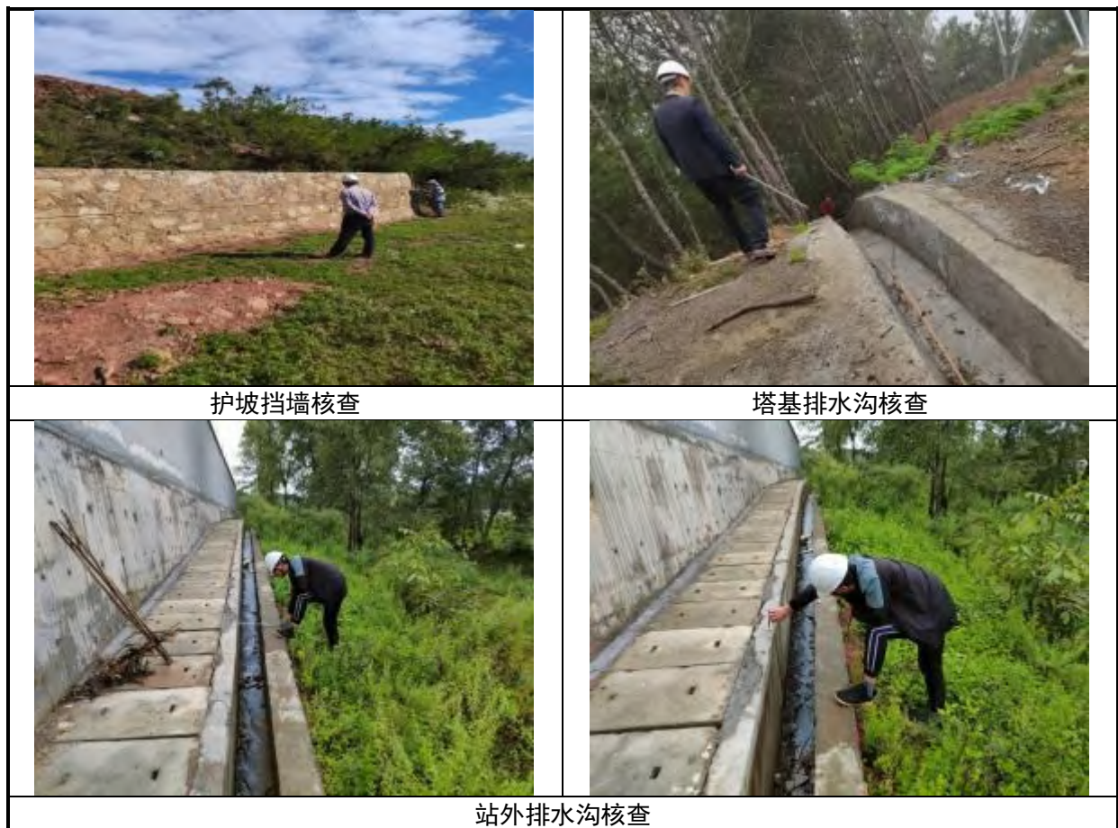
图 4-2 水土保持工程措施核查
